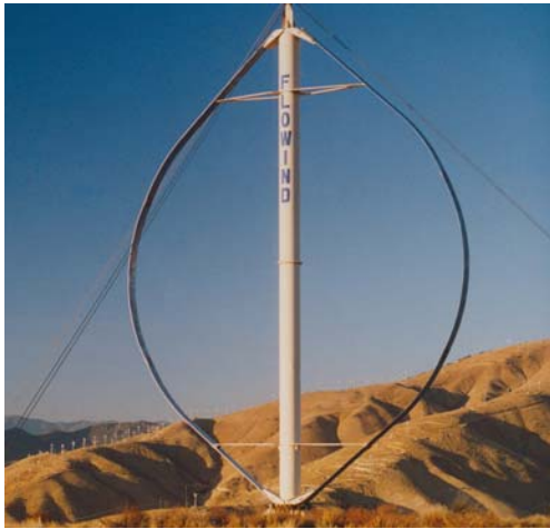
图2 Darrieus 式 Φ 型风轮
